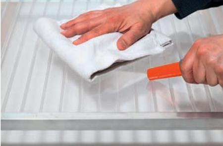
Bei PLEXIGLAS® Stegplatten mit AAA und NO DROP Beschichtung sollte die Funktionsschicht aktiviert werden. Das erfolgt durch den Regen, noch besser aber durch Abwaschen der Platten direkt nach der Verlegung (z.B. Hochdruckreiniger mit Breitstrahldüse).
